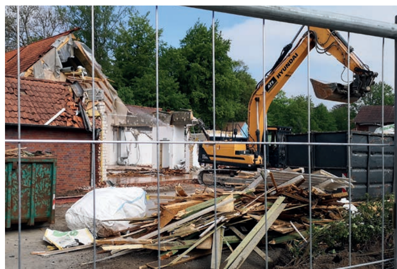
Abriss der Gebäude Wersehof und Edeka Rottthowe in Handorf, die Arbeiten werden vermutlich noch bis Ende Mai dauern. Sie dauern etwas länger, da alle Baustoffe getrennt (Holz, Metall, Steine usw.) gesammelt und entsorgt werden. Sehr vorbildlich! (Foto: Matthias Rack 2019)
